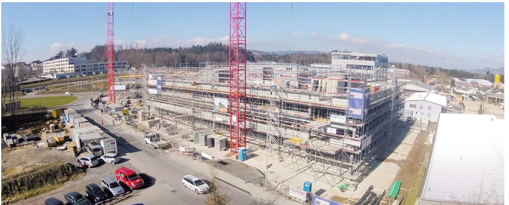
Das neue hochmoderne Geschäfts- und Wohngebäude an der Buchenstrasse in der Nähe des Bahnhofes Sursee nimmt Form an.
